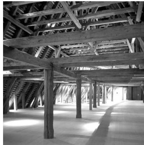
Sanierung Gotischer Kasten Gern
